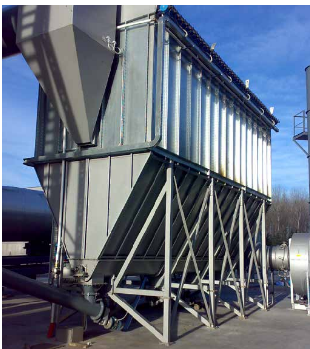
Esempio di filtro da 600 maniche con cestelli smontabili dall'alto.
